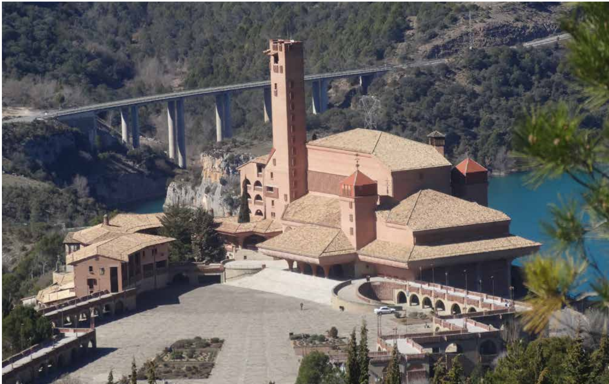
Santuario de Torreciudad. Vista desde la carretera a Ubiergo
